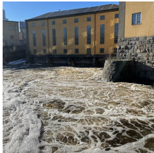
Figur 1. Strömmen i Norrköping, februari 2024. Foto SGS.
