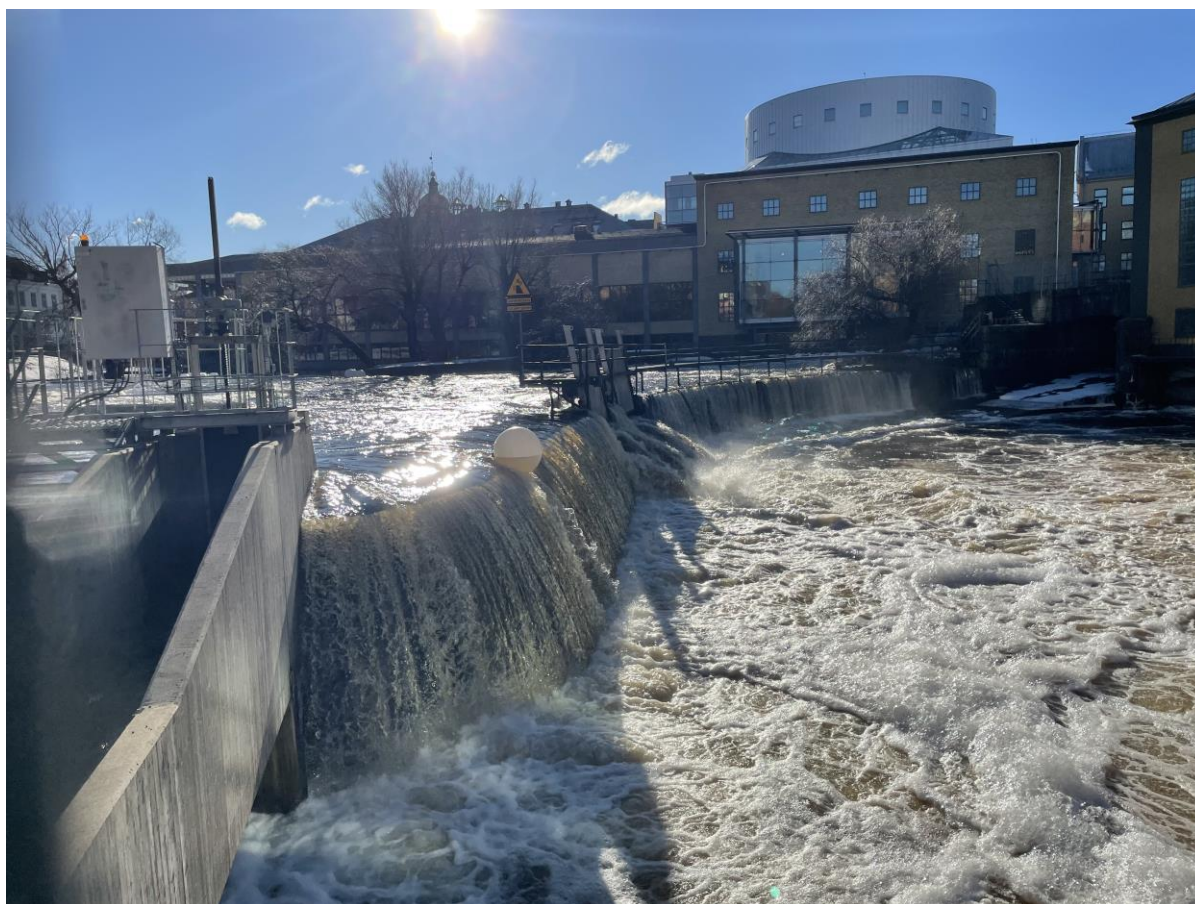
Figur 9. Strömmen i Norrköping, februari 2024. Foto SGS.
