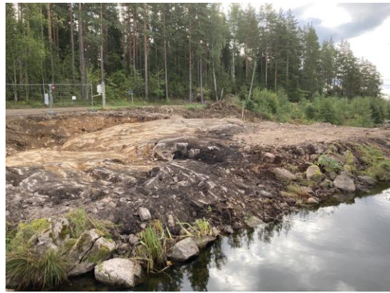
Figur 4. Sommens utlopp (Bo02) i september 2023, Motala ströms sydvästra vattenråd. Sänkning av vattennivån i samband med ny fiskväg i Laxberg. Foto SGS.
